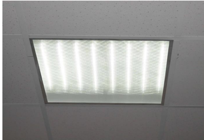
Рисунок 3.2 - Приклад виконання монтажу світильника СВО 01/43-2800/40
