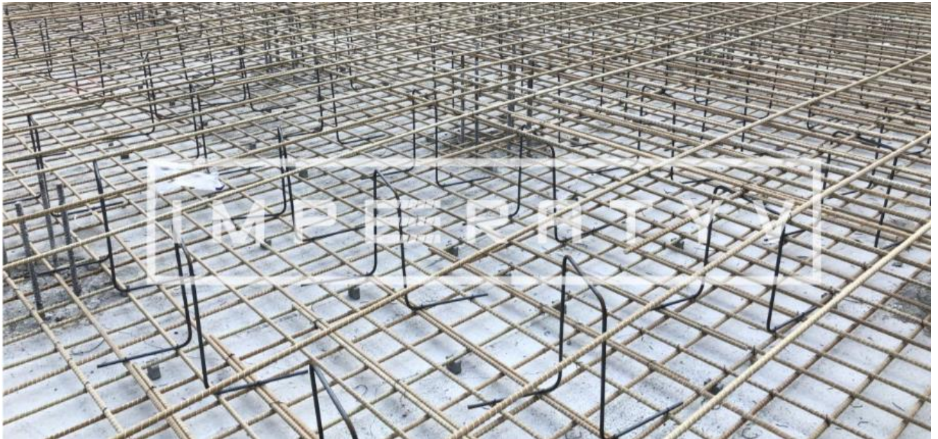
Рисунок 1.7 Армування басейну на очисній станції води в м. Вац, Угорщина
