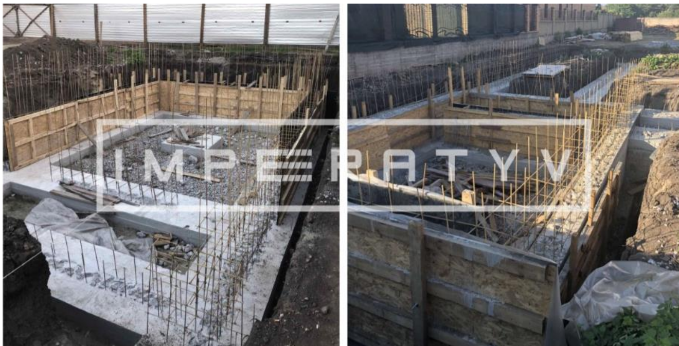
Рисунок 1.5 Будівництво приватного будинку з армування композитною арматурою
