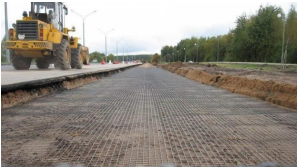
Рисунок 1.8 Застосування композитної сітки для влаштування дорожнього полотна
