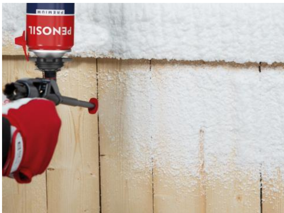
Рисунок 2.3 – Приклад нанесення пінополіуретану в балончиках за допомогою пістолету для монтажної піни [30]
