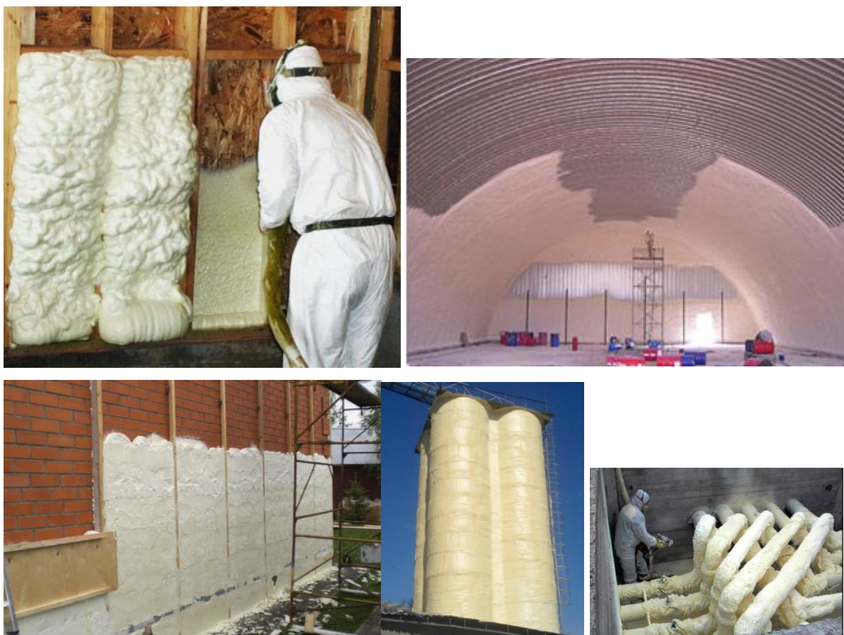
Рисунок 1.7 – Приклади утеплення пінополіуретановою піною, [28]
