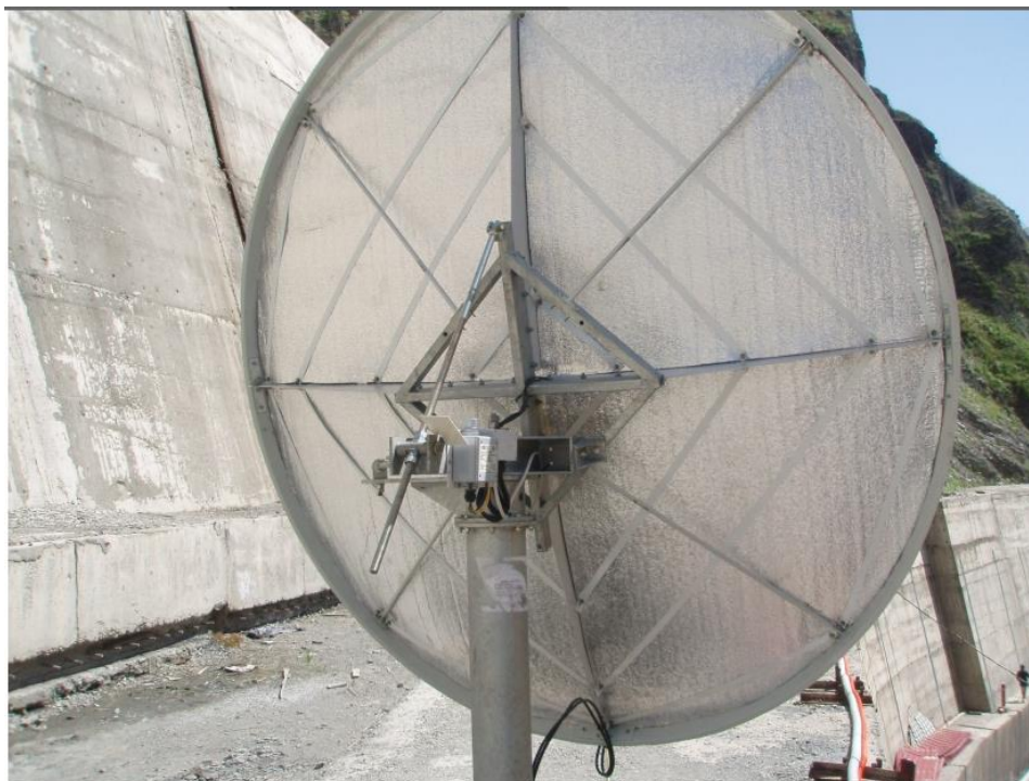
Рис.2.7. Вигляд системи антиобледеніння антенного поста 2,4 м
