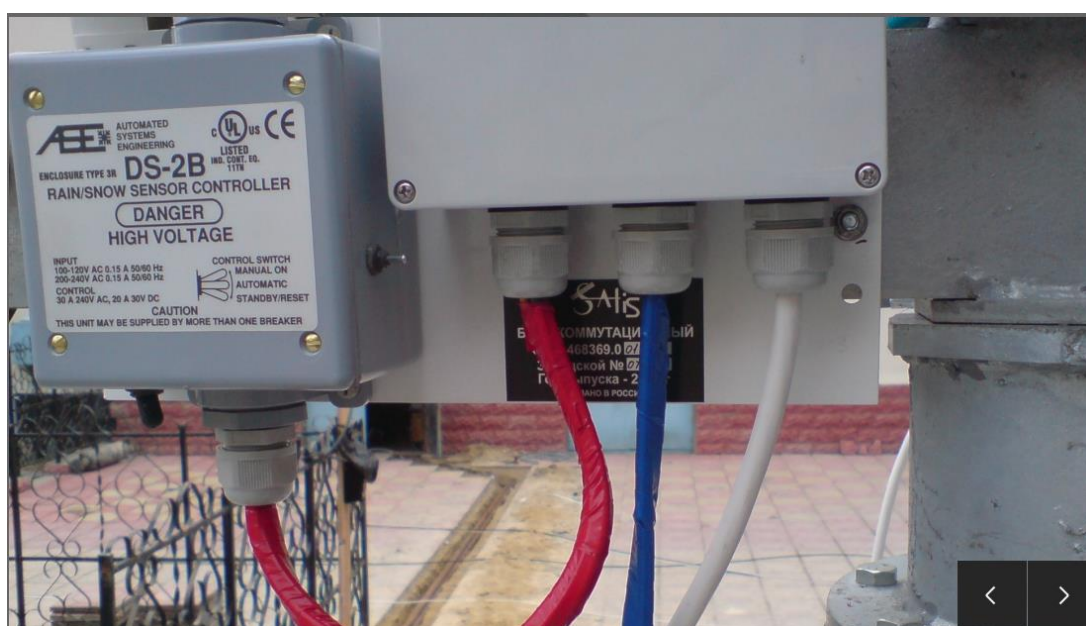
Рис.2.8. Підключення системи антиобледеніння
