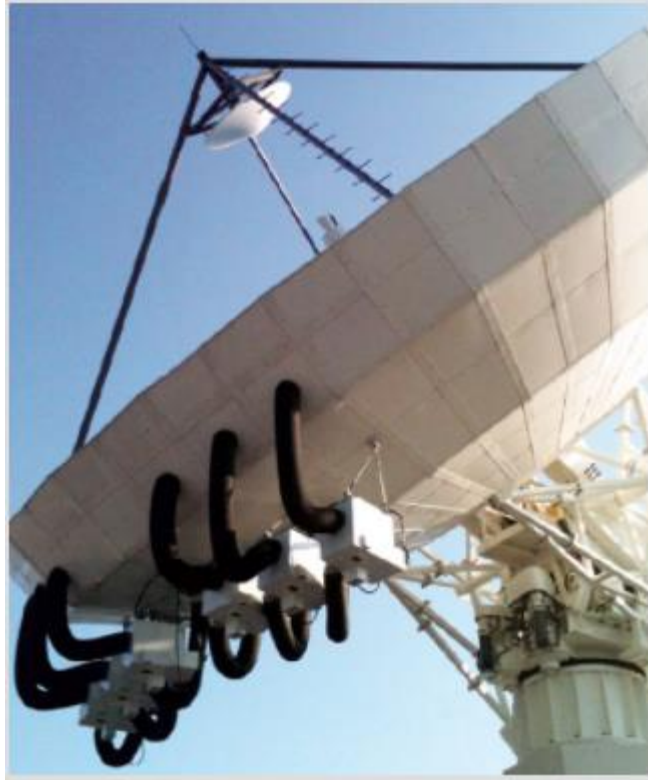
Рис.3.9. Зовнішній вигляд антенного обладнання
