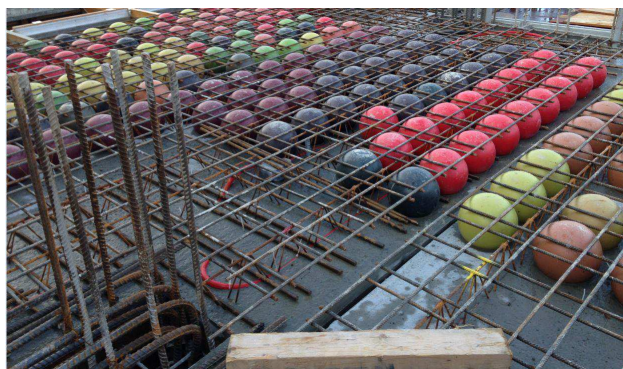
Рис.3.5 Зведення плити за технологією BubbleDeck
