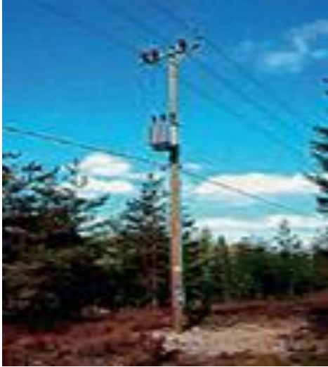
Рисунок 2.3 - Одномачтова ТП20/0,4 кВ
