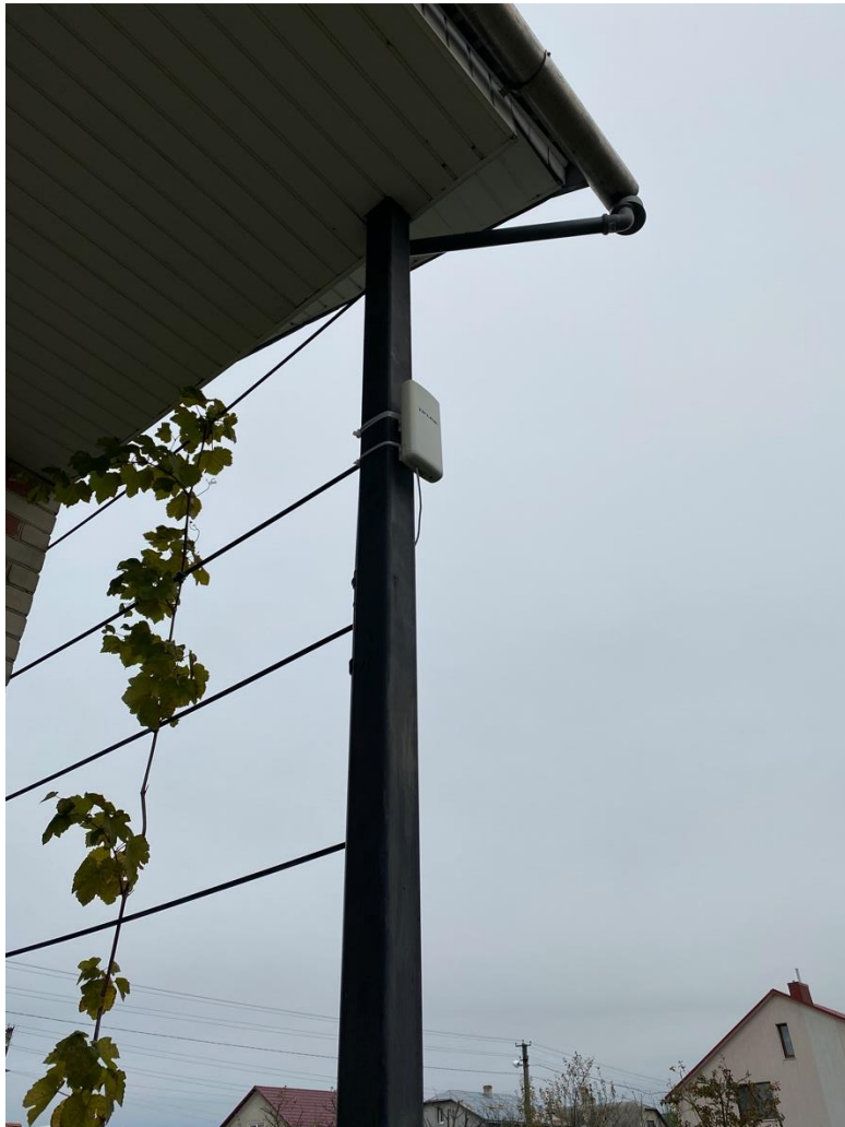
Рис. 2.4. Встановлення точки доступу на опору
