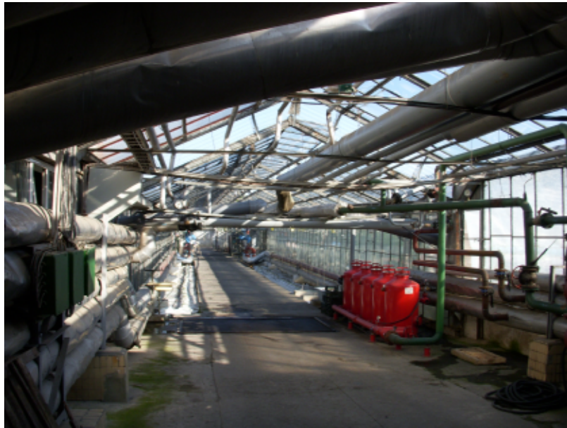
Рисунок 3.1 – Центральний пункт підготовки та розподілу води теплично-овочевого комбінату
