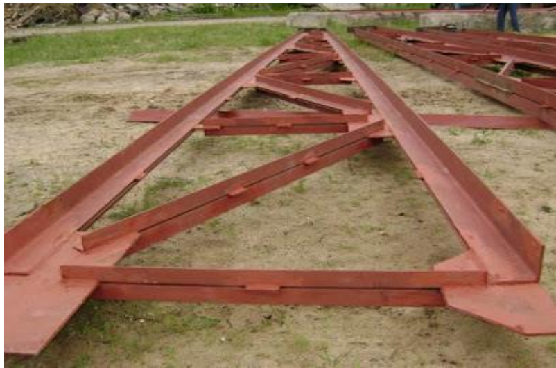
Рисунок 1.10 – Розміщення фасонки у зварній фермі
