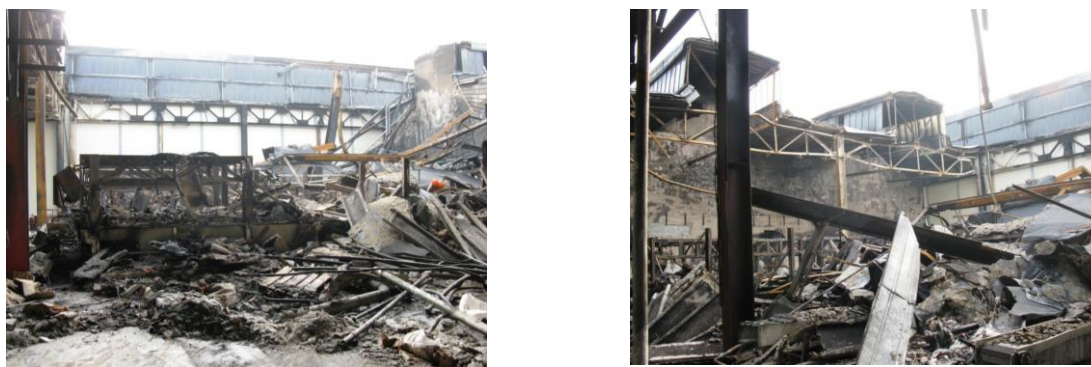
Рисунок 4.4 – Руйнування ферм при виникненні пожеж, вибухів
