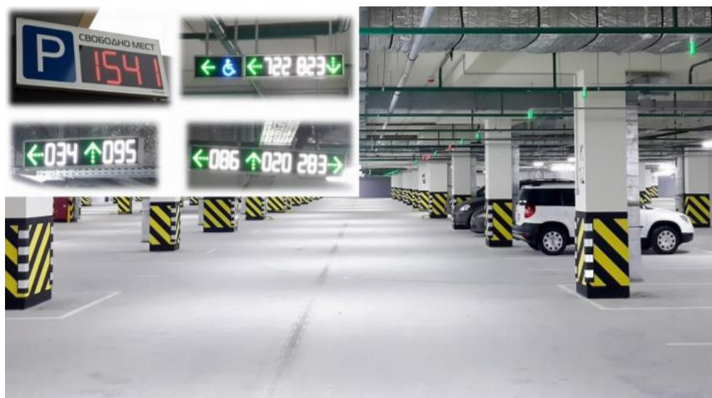
Рисунок 1.5 – Приклад системи навігації водіїв у AS101 ProPark
