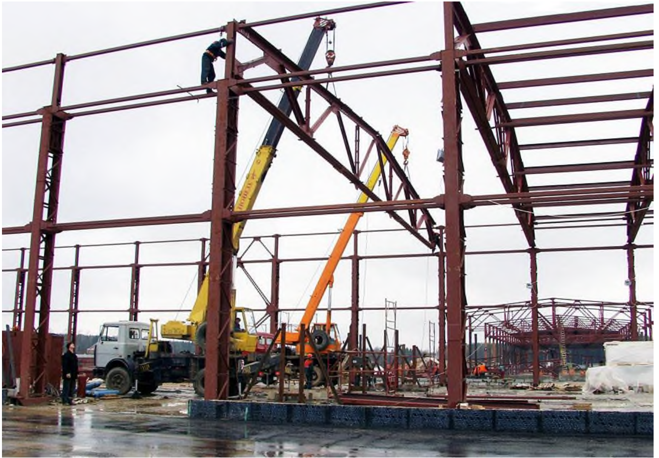
Рисунок 5.5 Монтаж ферми
