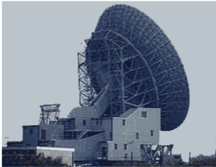
Рисунок 3.1– Центральна станція системи VSAT
