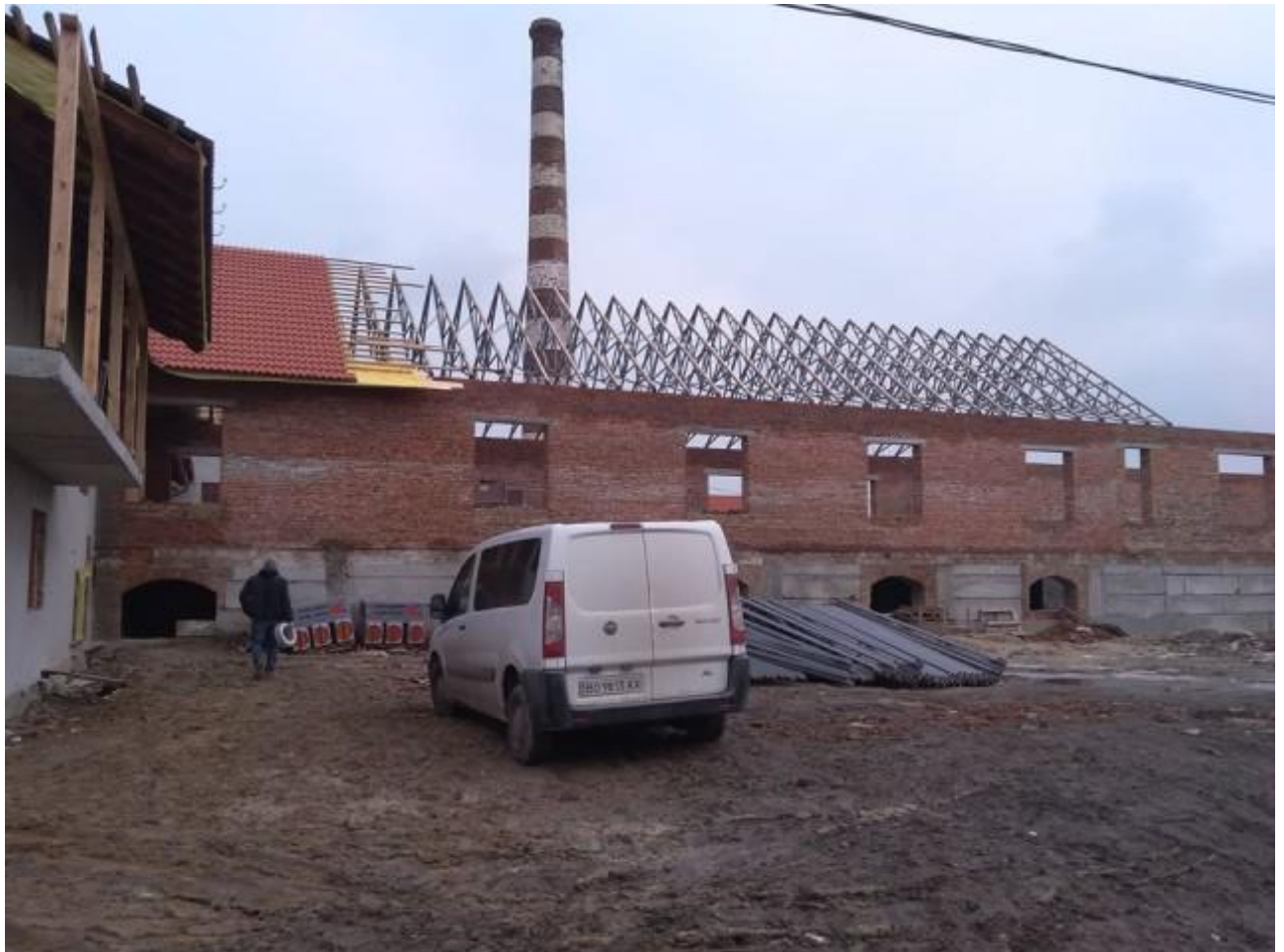
Рисунок 3.1 — Будівництво пивзаводу на території с. Глібів
