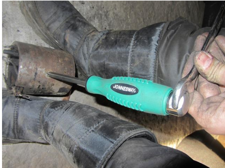
Рисунок 2.5 – Відкручування статорної обмотки
