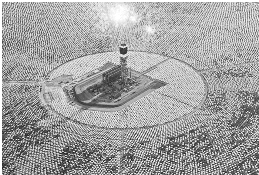
Рис. 1.8. Електростанція баштового типу з плоскими дзеркалами у якості концентраторів
