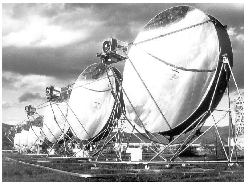
Рис. 1.2. Концентратор параболокругового типу з двигуном Стирлінга
