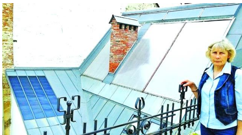
Рис.1.9. Зображення «Даху-батарейки» жительки Львова Оксани Денис Пані Оксана є спеціалістом з енергозбереження. Уже сім років подорожчання енергоносіїв цю жінку не бентежать. Її помешкання в самому
