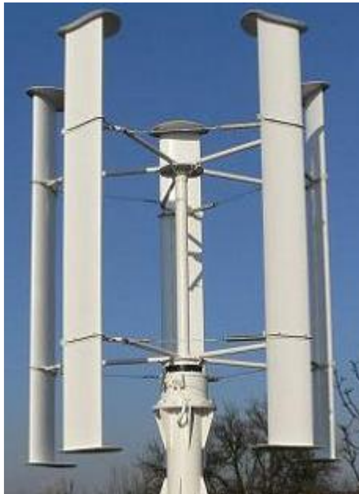
Рис.2.4. Ротор Н-типу
