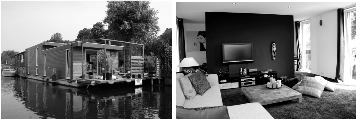
Рис. 3. [8] Плавучий мобільний будинок на каналі Vredenhofpad в Амстердамі (довжина 16,50 м, ширина 5,50 м, висота 4,50 м; внутрішній об'єм 372 м 3 ; площа 118 м 2 ); компанія «ABC Arkenbouw»
