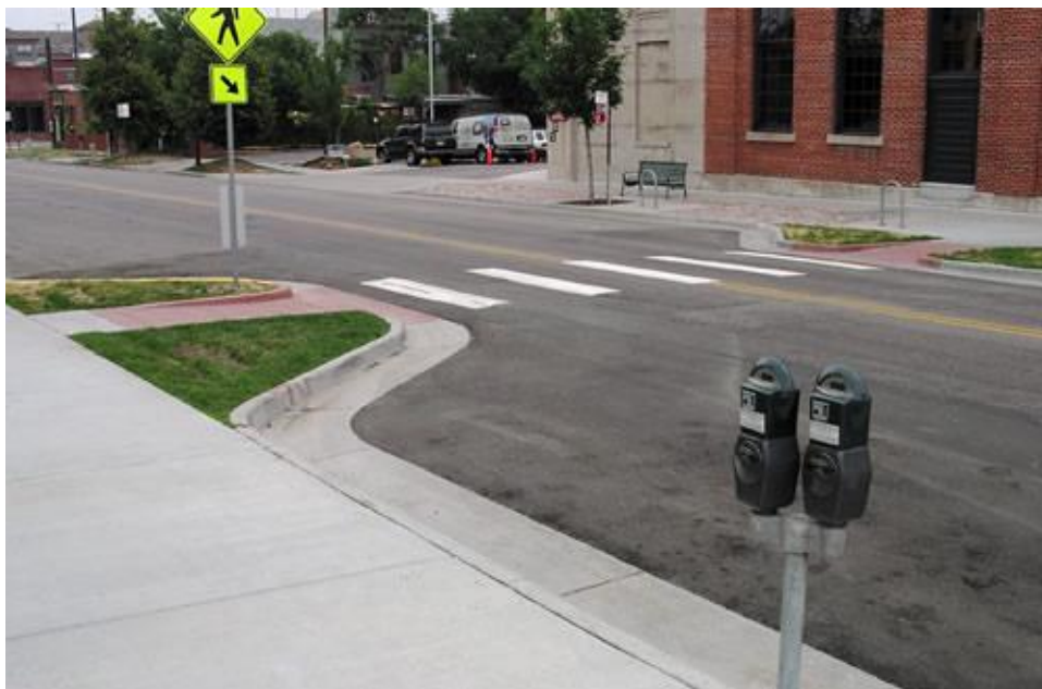
Рис. 1. Приклад облаштування розширення тротуару у місці пішохідного переходу
