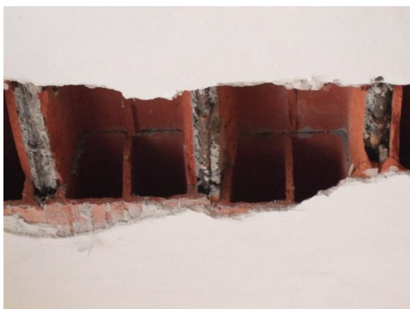
Рис. 1. Ділянка «1»: Вигляд знизу збірно-монолітного перекриття 1-го поверху
