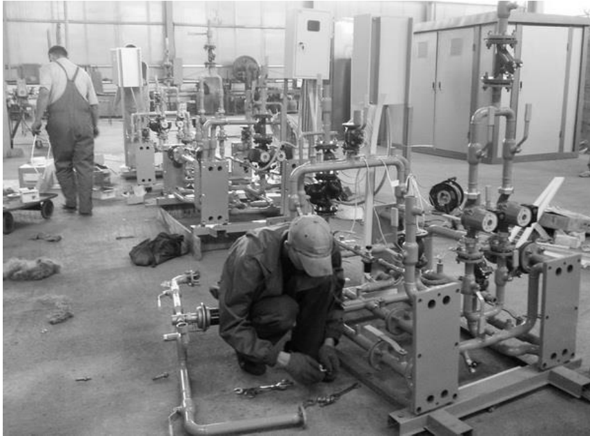
Рис. 9.8. Збирання блочного теплового пункту на виробництві
