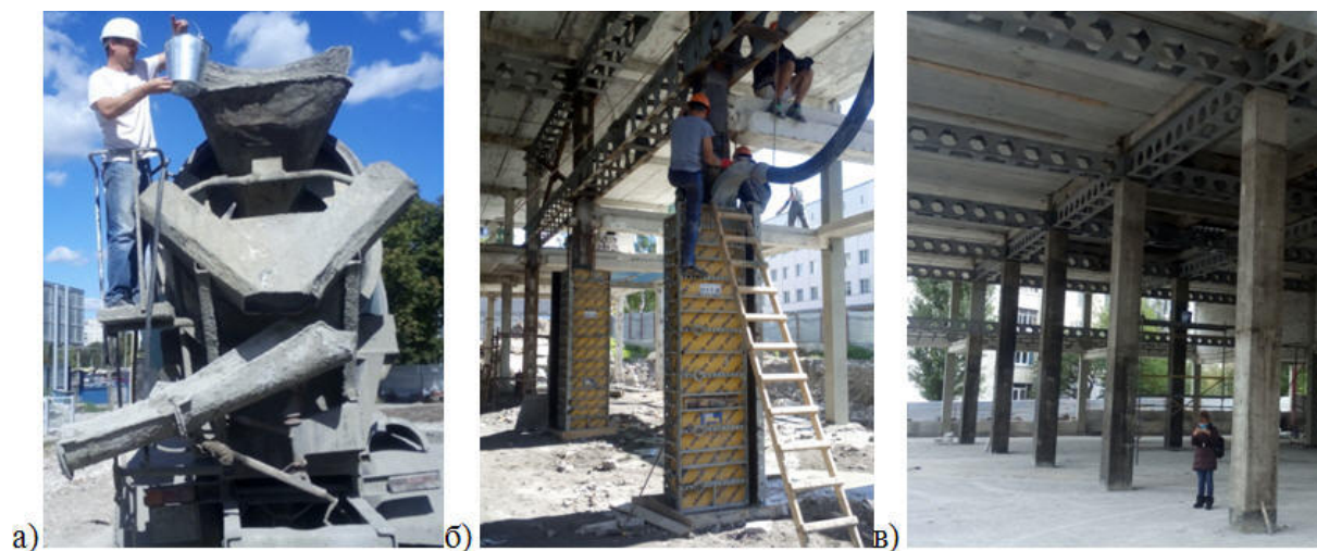
Рис. 2. Бетонирование колонн из самоуплотняющегося бетона: а) второй этап введения суперпластификатора; б) бетонирование усиления нижней части колонны; в) готовые колонны после усиления
