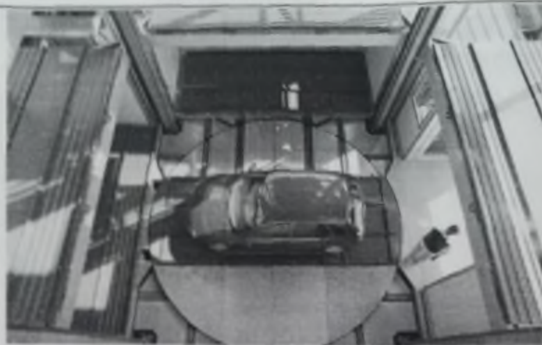
Рис. 3- Платформа підійомно-спускового механізму із завантаженим автомобілем [5]
