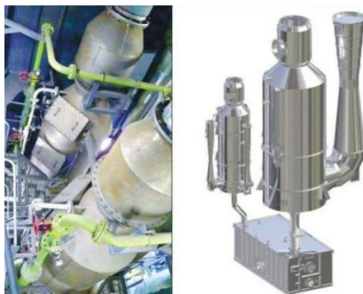
Рис. 2. Скрубер гібридної конструкції (замкнутий та відкритий цикли)
