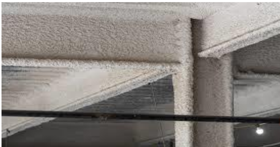
Рис 3.7 . Методи захисту металоконструкцій від високих температур
