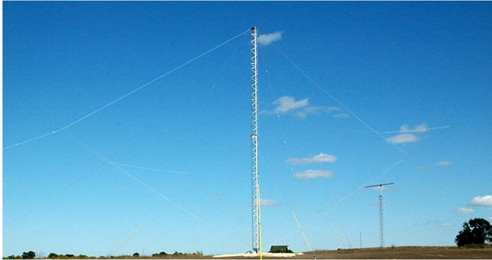
Рис. 1.4. Зовнішній вигляд монопольної антени
