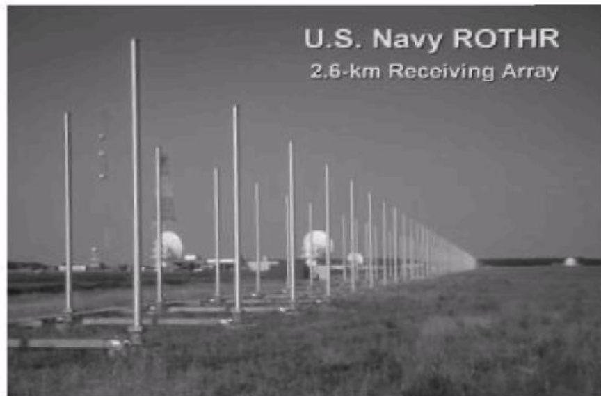
Рис. 1.9. Загоризонтна станція радіолокації U.S. Navy Relocatable Over The Horizon Radar (ROTHR), що працює на частоті 5-28 МГц.
