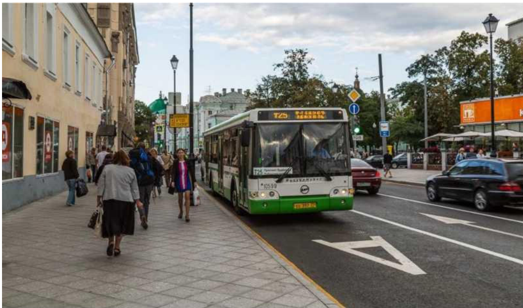
Малюнок 2.6 - Виділена смуга громадського транспорту, відокремлена назустріч основному потоку транспорту
