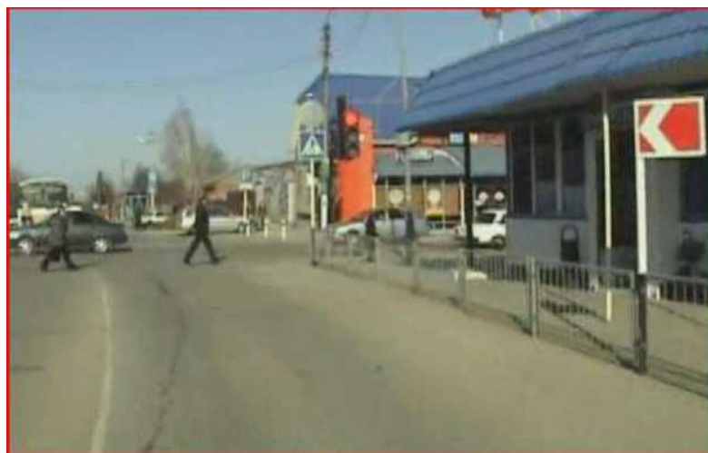
Малюнок 1.20 – Відсутність бічної видимості на регульованому перехресті
