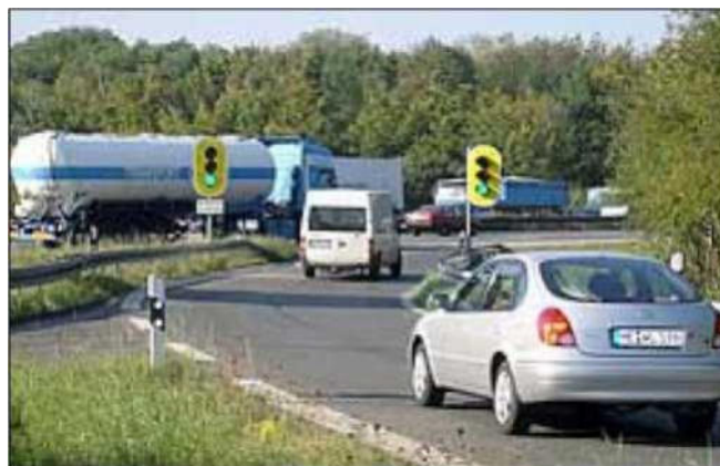
Малюнок 1.7 – Регульоване примикання для дозування кількості автомобілів, що в'їжджають, на автомагістраль в Німеччині [9]
