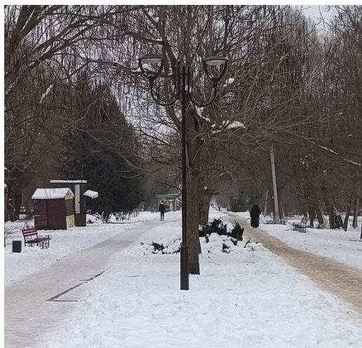
Рисунок 2.2 – Застосування світильників типу ДТУ 20У виробництва ТОВ «ОСП Корпорація «ВАТРА» в системі освітлення алеї 15
