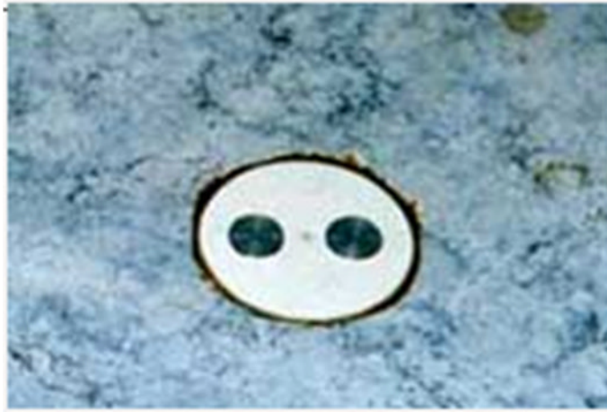
Рисунок 3.2 - Вид датчика протічки води, вмонтованого в плитку
