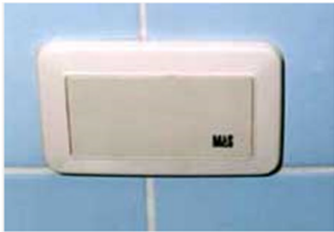
Рисунок 3.3 - Вид порту системи запобігання протікання води
