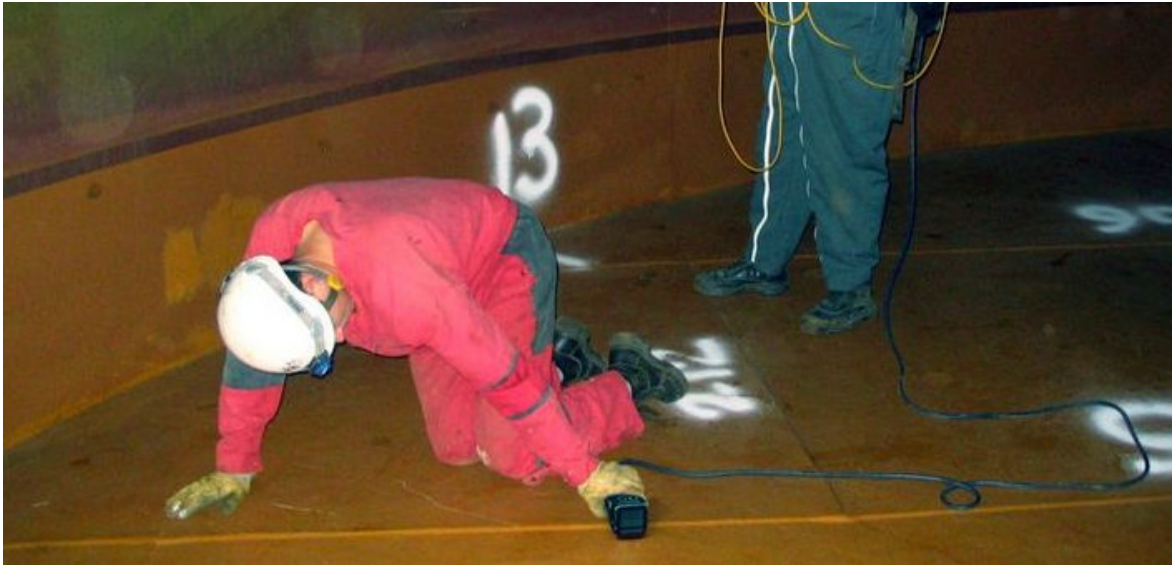
Рис. 1.5. Аналіз зварних швів днищ резервуарів (АСФМ)
