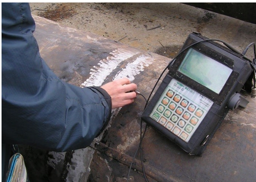
Рис. 1.6. Ультразвуковий контроль зварного шва труби
