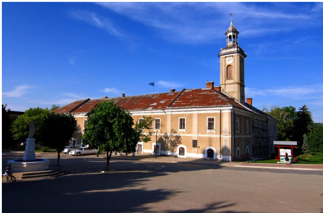
Рис. 3.2. Бережанська ратуша. Вигляд із центральної сторони міста, де буде розташоване кафе.
