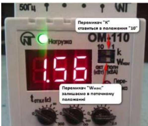
Рис. 6.2. Налаштування обмежувачів потужності
