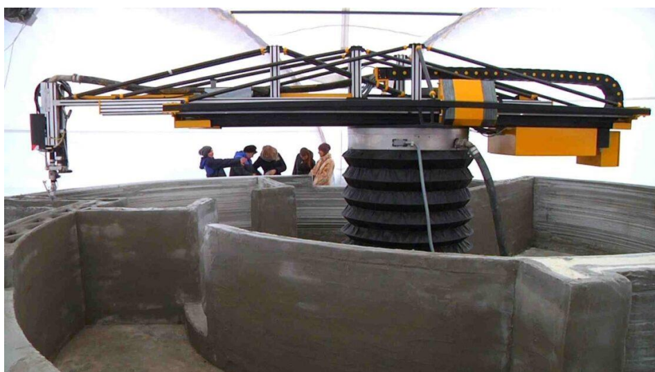
Малюнок 1.2.1 Будівельний 3D-принтер в дії
