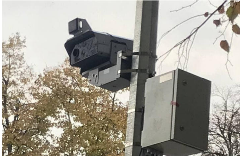
Рисунок 2.16 - Опора системи фіксації порушень ПДР «КАСКАД»
