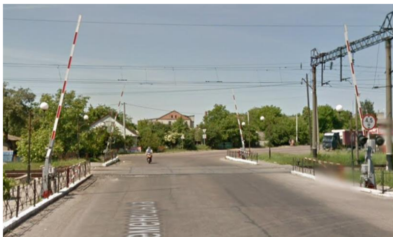
Рисунок 2.19 - Автоматичні ворота (шлагбаум) залізничного переїзду
