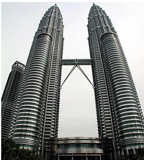
Рисунок 1.2 - Каркасно-стовбурна система "Петронас Тауер", м. Куала Лумпур, Малайзія
