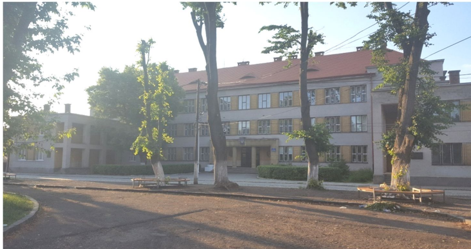
Рисунок 2.1 – Зображення будівлі Хустської спеціалізованої школи № 1 імені Августина Волошина
