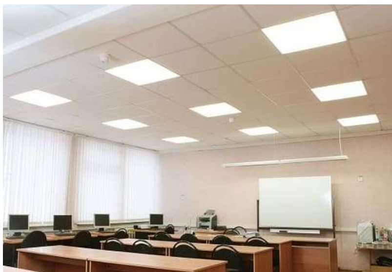
Рисунок 1.2 – Зображення системи комбінованого освітлення навчального кабінету
