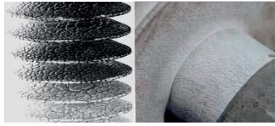
Рисунок 2 - Тріщини на поверхні ізолятора глибиною більше 0,1 мм
