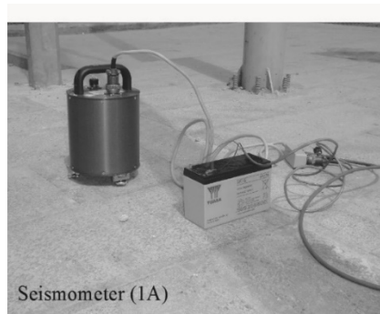
Рис. 3.1 – Пристрій вимірювання коливань в реалізованих будівлях
