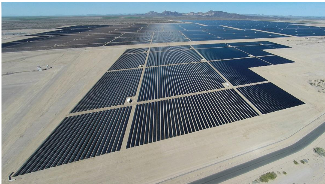
Рисунок 1.2 – Сонячна ЕС Agua Caliente Solar Project в Арізоні, США 290 МВт, 971 Га, кап. Витрати $1,8 млрд, персонал 16 осіб, 2011
