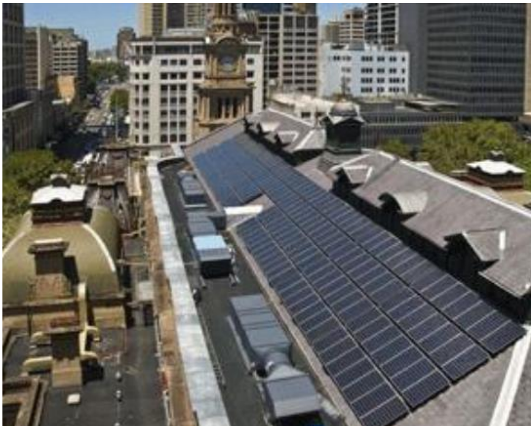
Рисунок 1.11 – Монтаж фотоелектричних BAPV модулів на даху будівлі.
