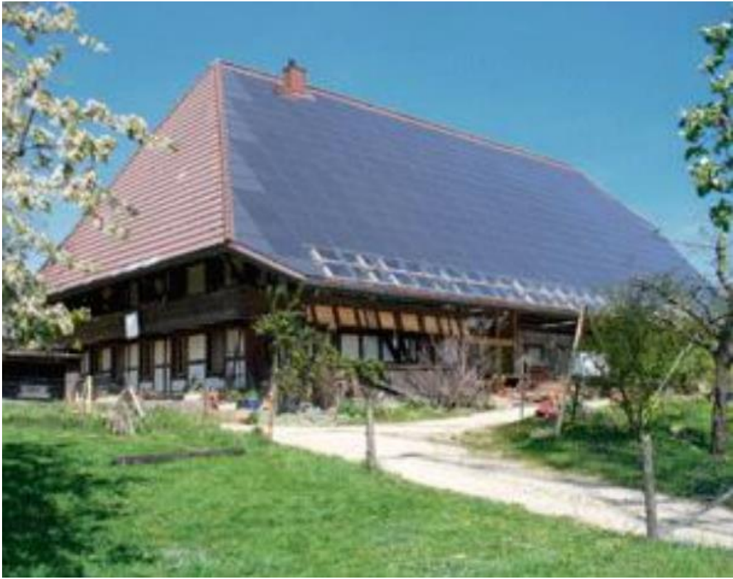
Рисунок 1.12 – Фотоелектрична установка змонтована з модулів ВІРV які є елементом даху.
