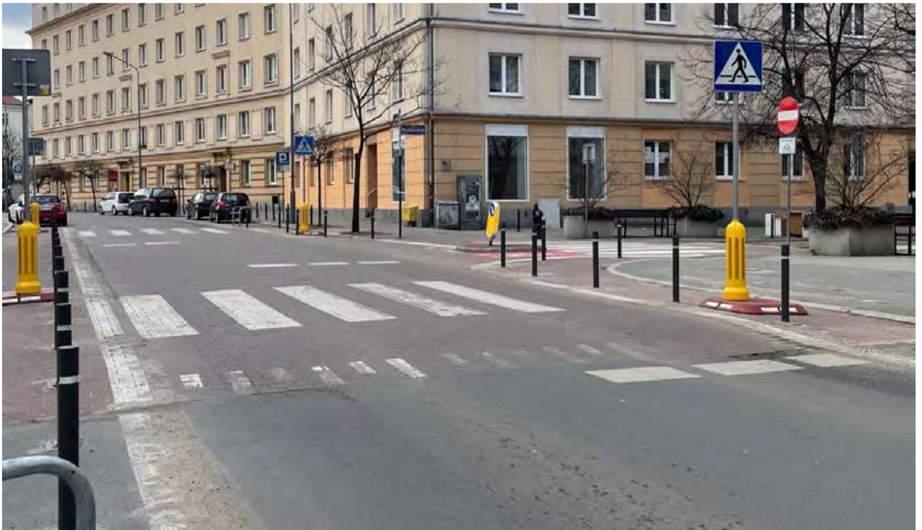
Рисунок 1.5 – Підняті перехрестя з пішохідними переходами
