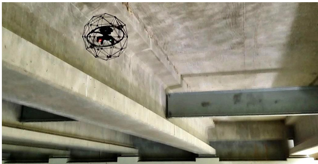
Рис. 1.1 – Обстеження моста за допомогою захищеного дрона Elios
