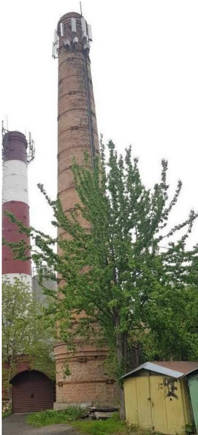
Рис. 2.3 – Загальний вигляд цегляної димової труби
