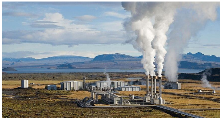
Рисунок 1.2 – Геотермальна електростанція Несьявеллір в Ісландії.
