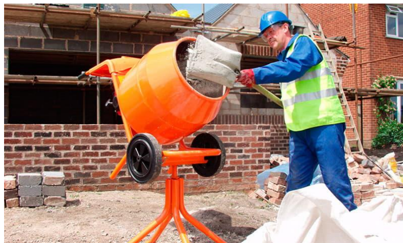
Рисунок 1.8 - Процес приготування бетону
