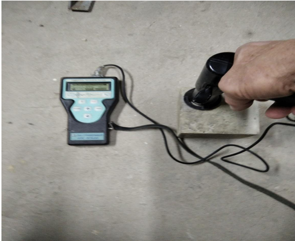
Рис 3.9 Визначення твердості бетону приладом ІПС-МГ4.03
