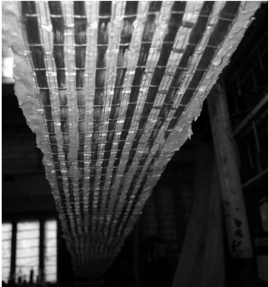
Рисунок 17. Накладання сітки Ruredil X Mesh Gold.
