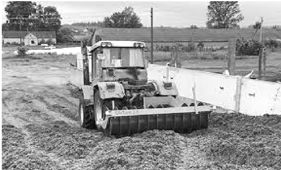
Утрамбовування силосу у траншеях
