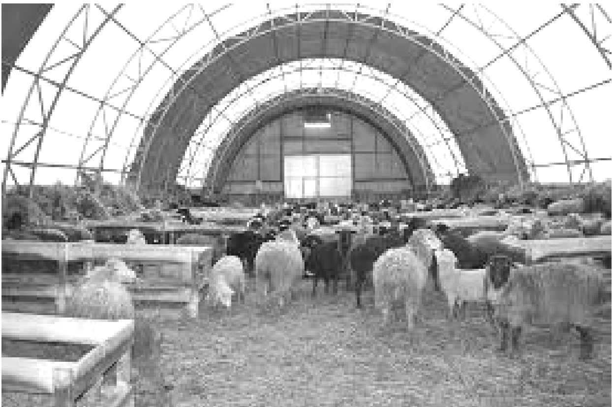
Рисунок 22.8 – Загальний вигляд вівцеферм (будівлі ангарного типу)
