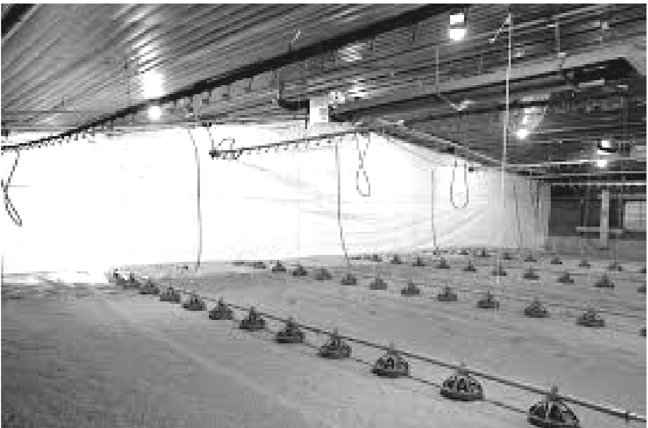
Рисунок 23.32 – Загальний вигляд каркасного пташника і внутрішнє обладнання
